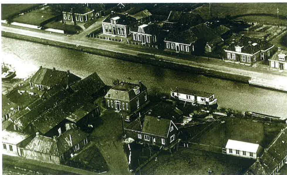
De huisjes links op de foto vormden de gekochte eigendommen in 1869. Links naast de woningen is nog de inham te zien waar de pramen altijd lagen.
